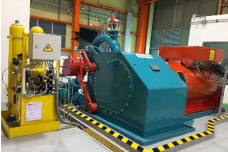
**Turbinas Hidráulicas de Paso** fabricadas en Austria con tecnología Alemana, del tipo Pelton eje Horizontal y Vertical, cada unidad con una potencia de 1.1 MW.
